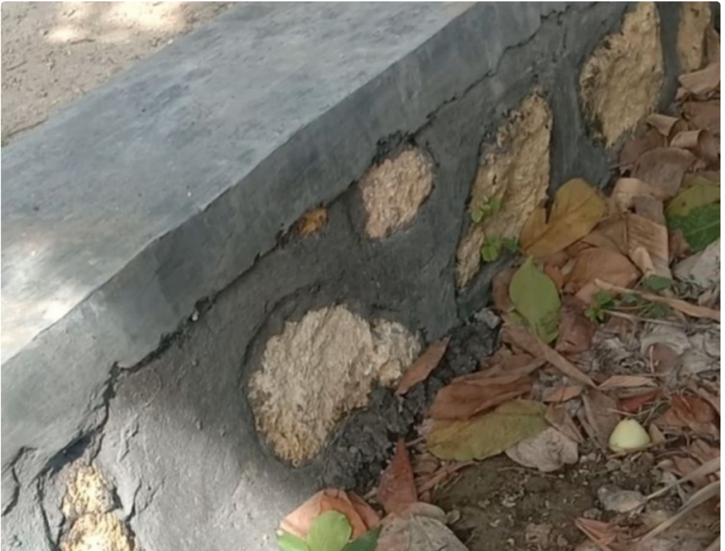
Proyek plengsengan di dusun Mandala Desa Sejati Kecamatan Camplong
